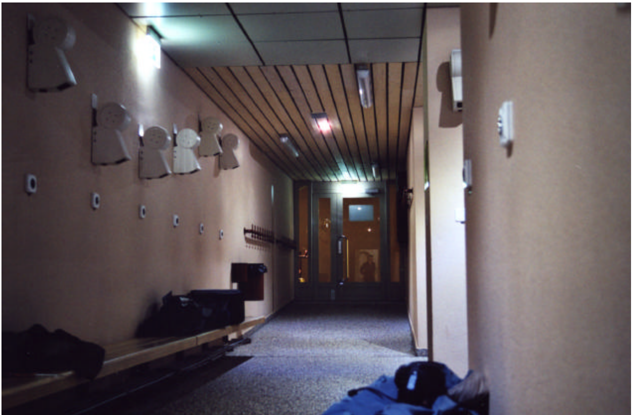
Couloir de sortie des vestiaires de la piscine de Vailly à BERNEX ( vide d'étage de 2,7m. )
